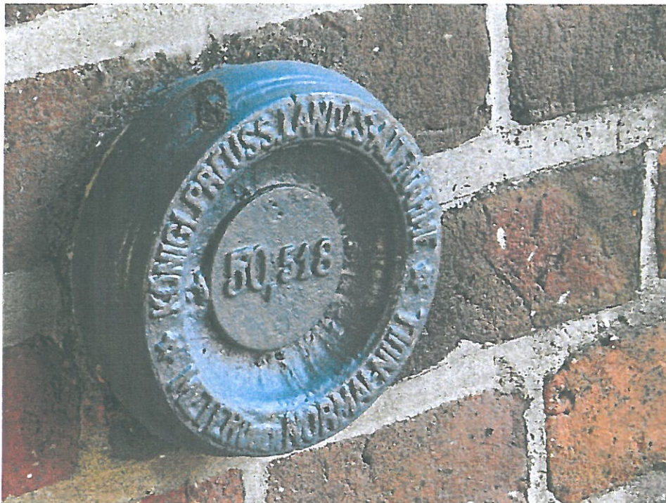
Pruski reper na zachodniej fasadzie ratusza w Toruniu
